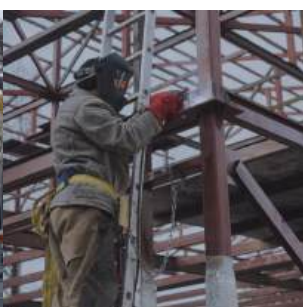
Строительство, монтаж металлоконструкции
