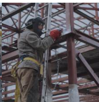
Строительство, монтаж металлоконструкций
